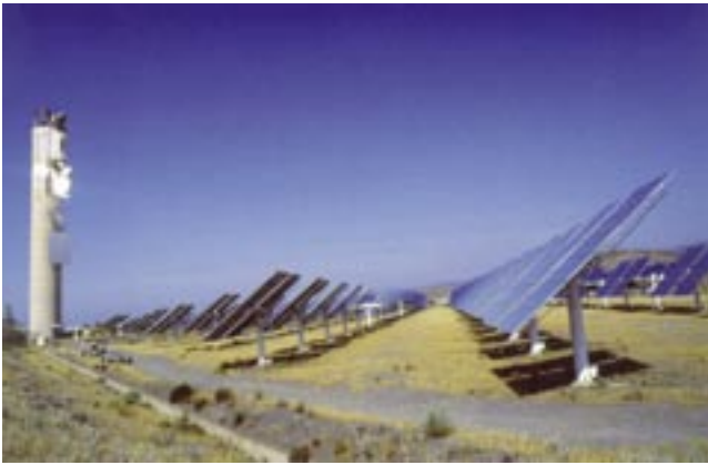
Solarthermisches Kraftwerk in Spanien
